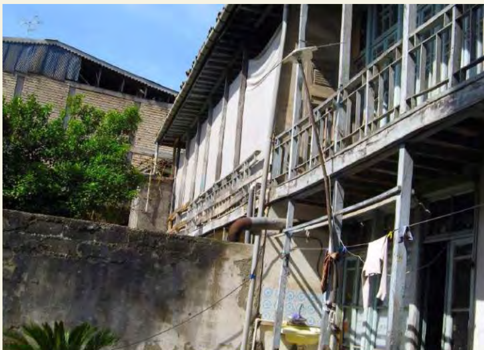
شکل ۲۴۹. دید به نمای اصلی خانه از حیاط که در آن نحوه اتصال خانه به همسایه قابل مشاهده است. (منبع: علیخواه و دیگران، ۱۳۸۹)
