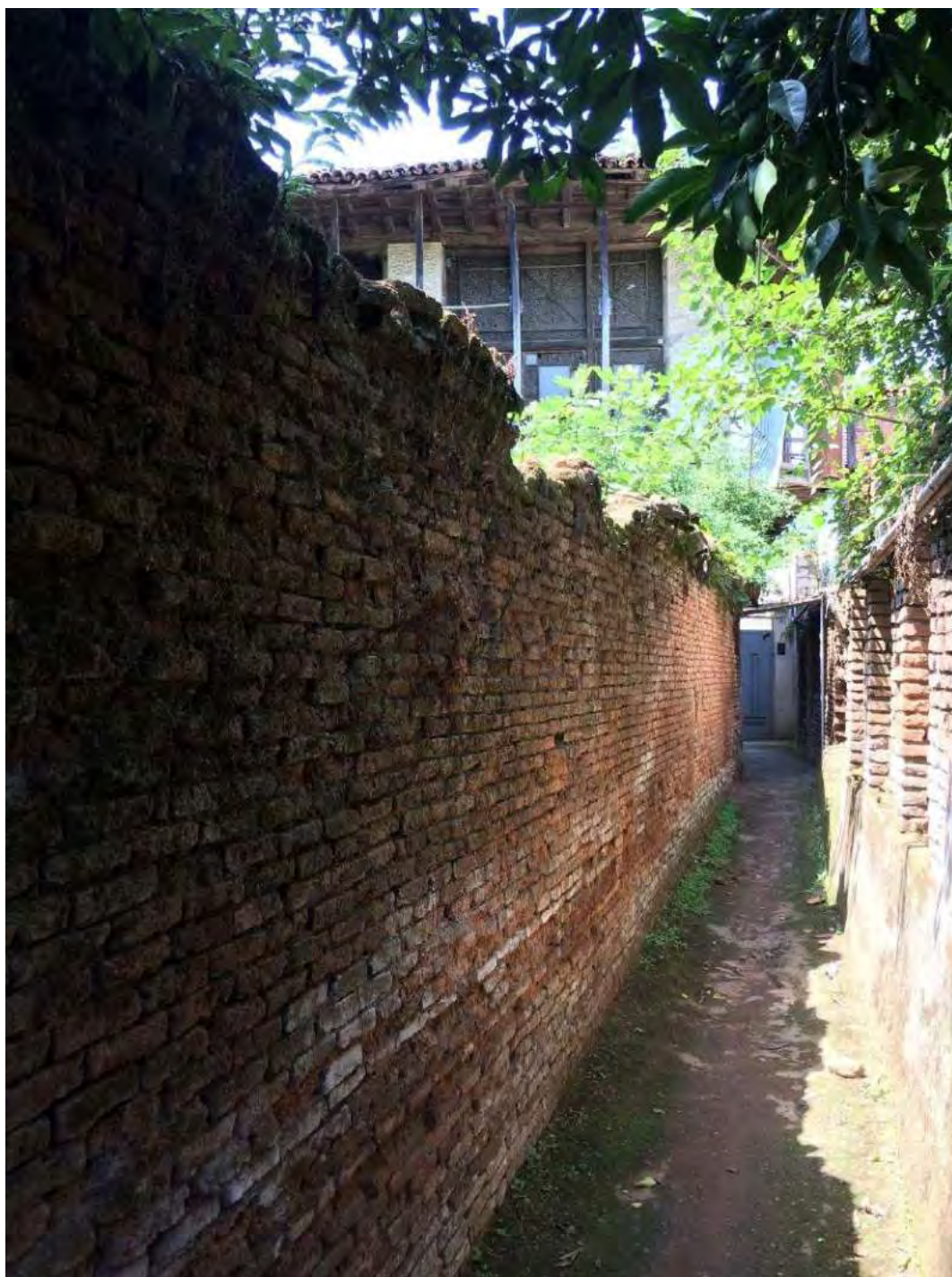
شکل ۴۴. دیوار مجاور معبر خصوصی در خانه دوزنده حدود ۵۰ رگ آجر ارتفاع دارد.
