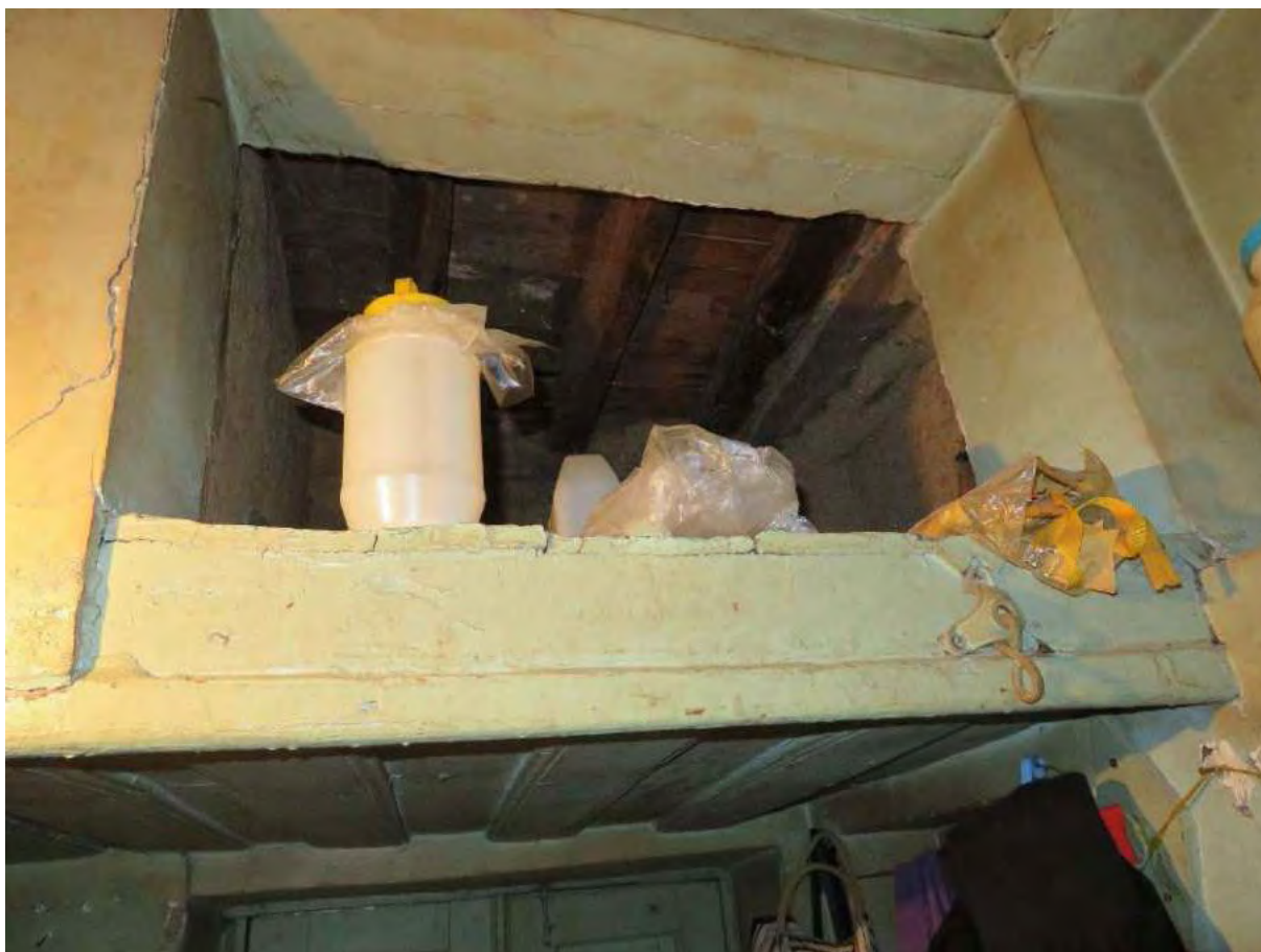
شکل ۱۳۳. در خانه مجمع صنایع از فضای زیر پله به عنوان انبار سقفی استفاده شده است.
