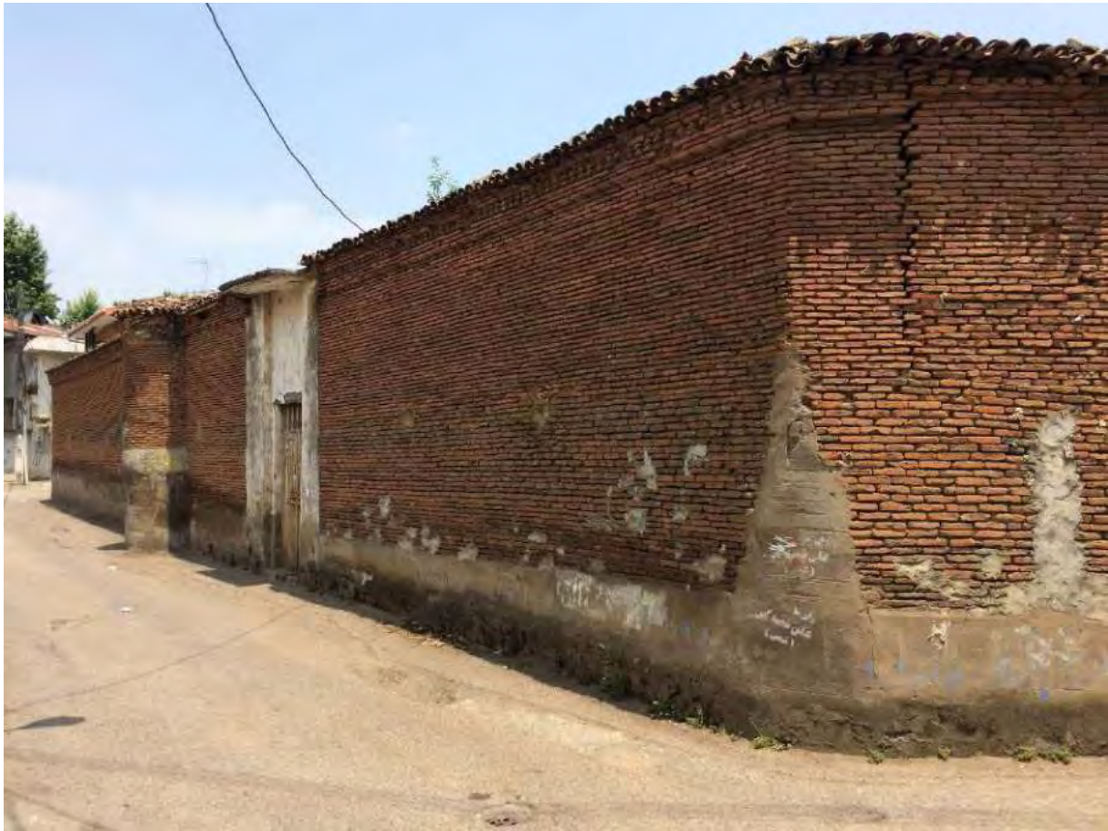
شکل ۵۵. خانه منتصرالملک در محله میدان (و یا یحیی آباد) لاهیجان که با الگوی قلعه ای احداث شده بود.
