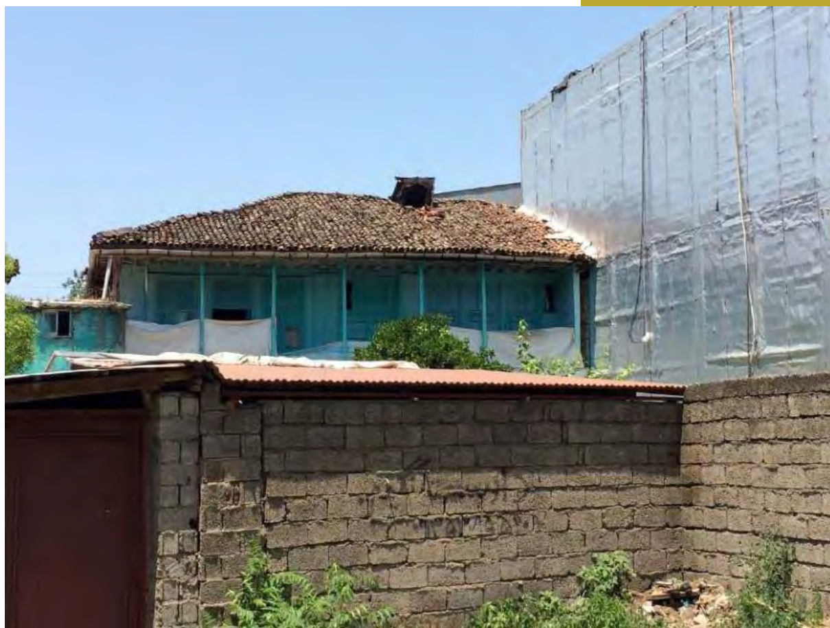
شکل ۲۵۱. وضع موجود در سال ۱۳۹۷: خانه احمدی پور تخریب و نوسازی شده ولی ساختمان همسایه آن موجود است.
