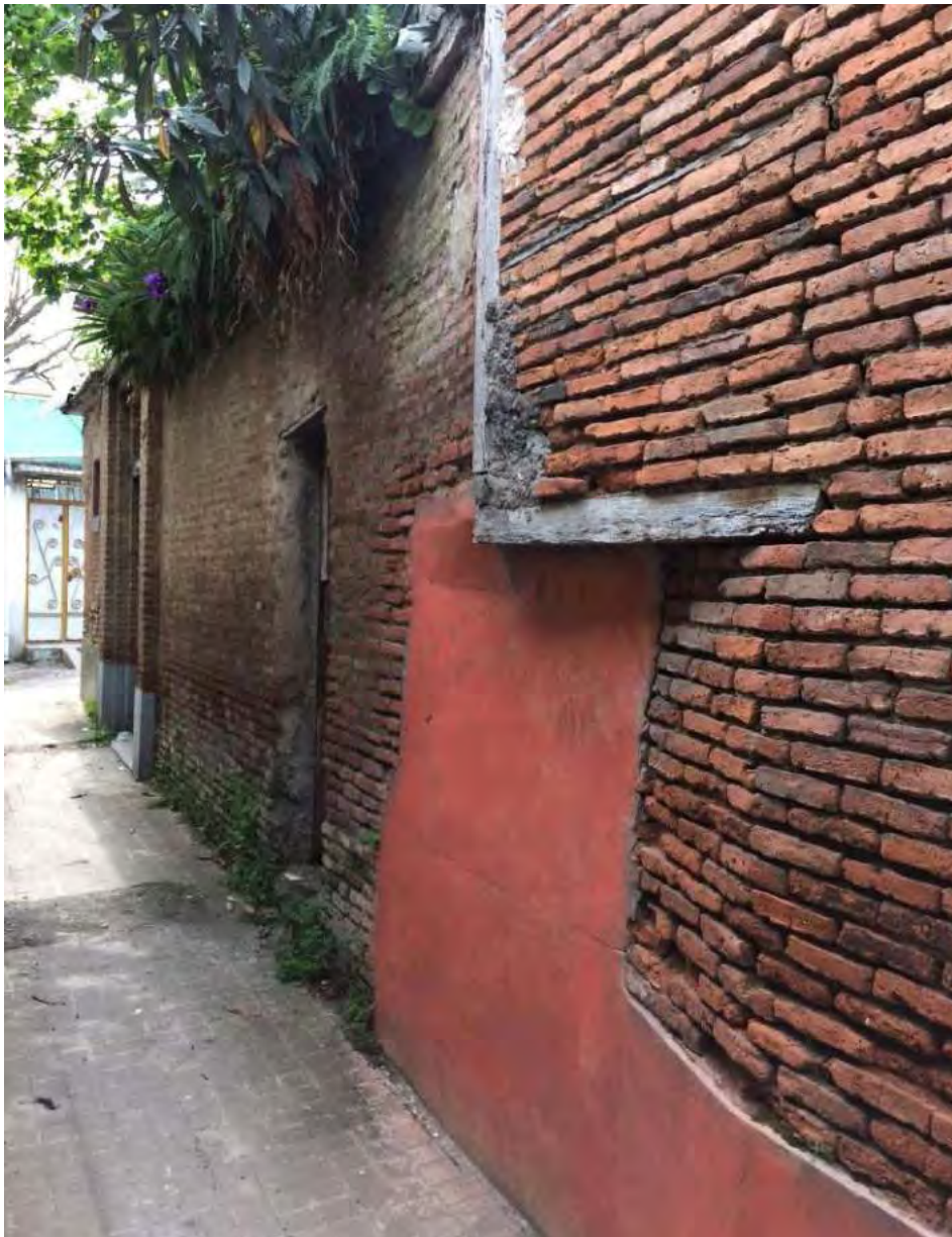
شکل ۵۹. پیشروی امتداد دیوار ایوان طبقه همکف بر روی معبر عمومی در خانه شکوری
