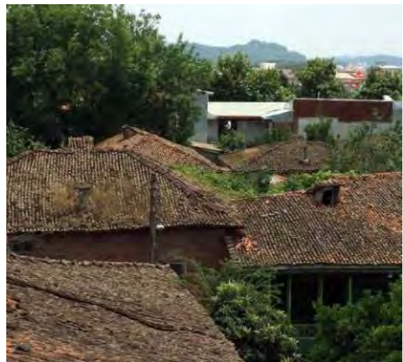
شکل ۱۷۵. یکی از خصوصیات بارز بومی معماری لاهیجان بام های سفالی آن بوده است (منظر شهر از مناره مسجد اکبریه)
