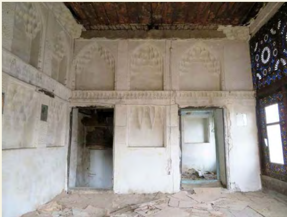
شکل ۱۳۸. تناسب سه به پنج اتاق مهمان در خانه دوزنده از تاقچه بندی آن قابل تشخیص است.
