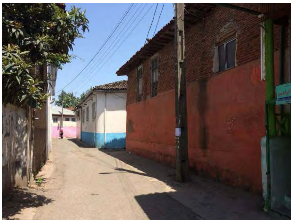
شکل ۵۰. خانه یک طبقه در مقابل مسجد اکبری (خانه شکوری) که پنجره های کوچکی در ارتفاع بالا نسبت به معبر مجاور دارد.
